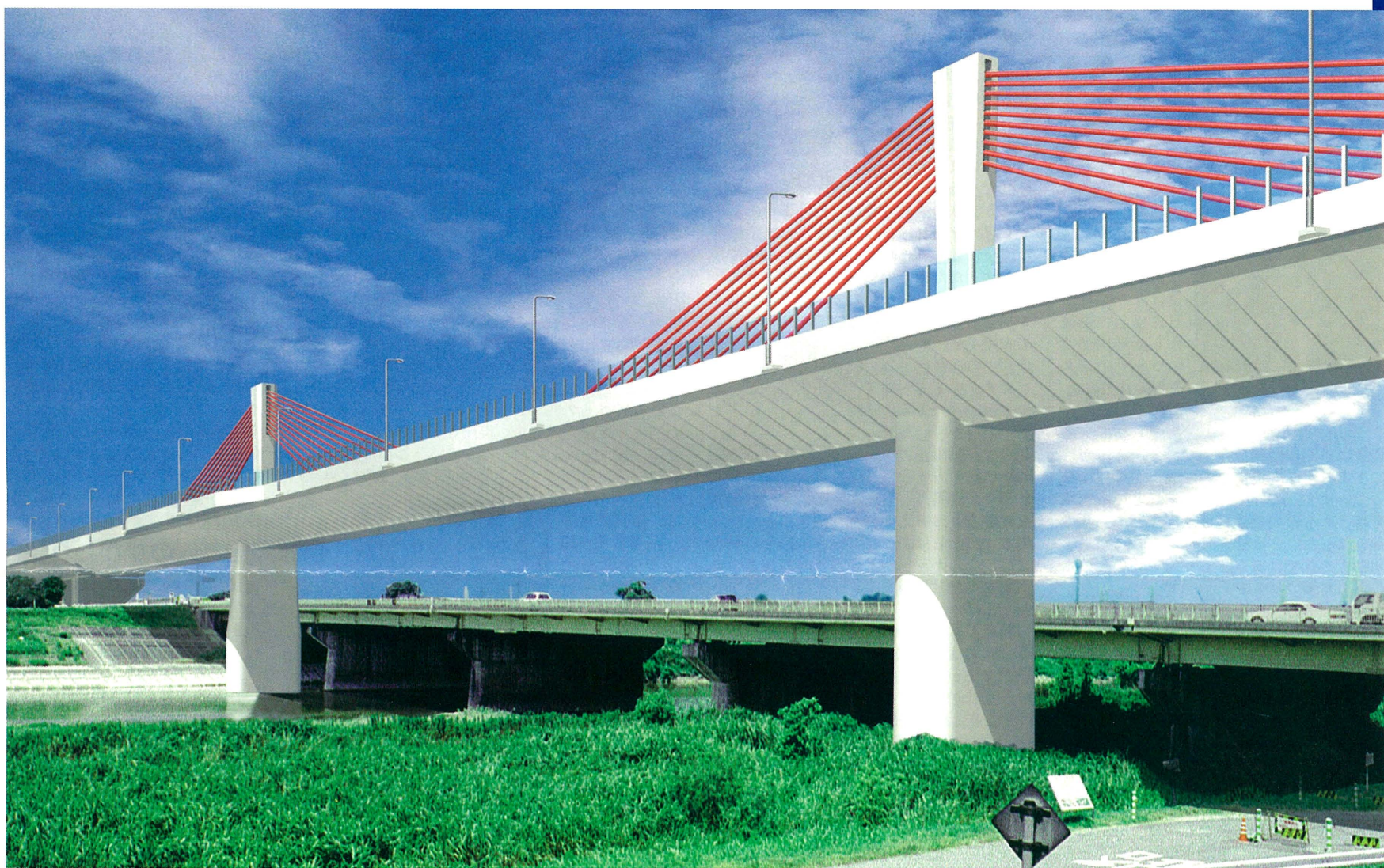
名古屋高速6号清洲線 1面吊りエクストラードズド橋 (完成予想図 左岸下流側より新名西橋方向を見る)
