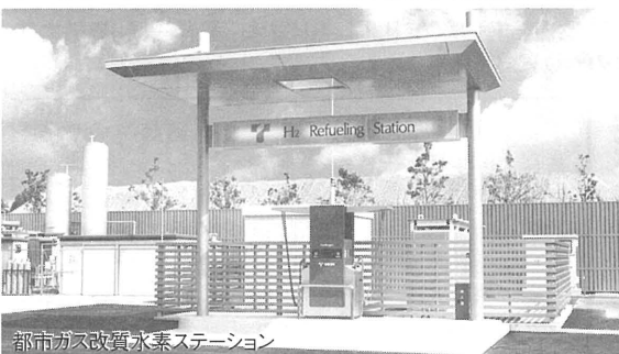
都市ガス改質水素ステーション
