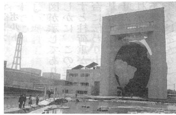
▲中電川越火力発電所
